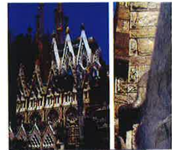
● Encadrée d'échafaudages la nef (3) prend tournure. Sur les contreforts du chœur (11) courent des sauriens de pierre.
